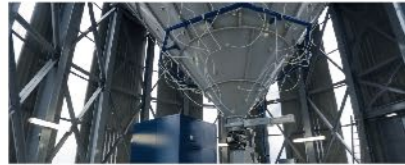
Aeration system IF and PF on silo's cone. Sistema de aireación IF y PF en cono del silo.
