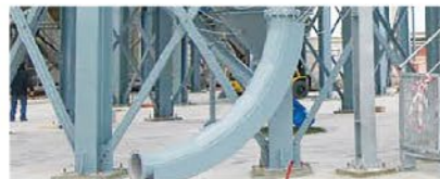
Detail of pneumatic fill pipe. Detalle de tubería de llenado del silo.
