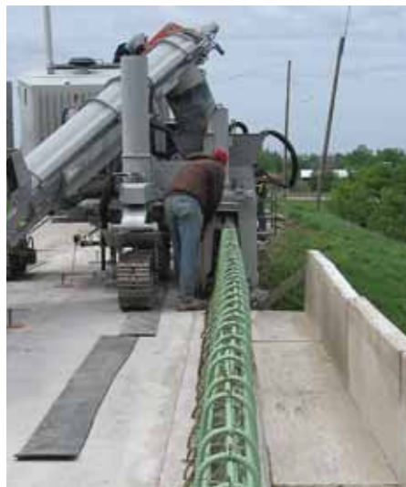
Pouring barrier over rebar cage.
